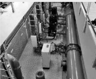
Pumpenkammer des Wasserwerkes Tettau mit den Rohrleitungen und Pumpen zur Versorgung der einzelnen Netzbereiche des Wasserverbandes Lausitz
