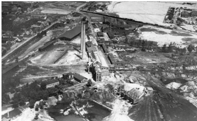
Abbildung 2: Trasse der Fabrikstraße von links unten bis zu den Brikettfabriken, um 1923. Vorn mittig befindet sich heute das ATZ und der Epochenarten; Quelle: Archiv Uwe Kulke
